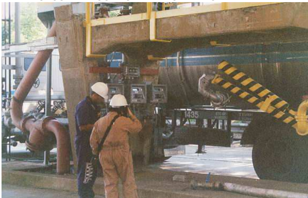
Carregamento de caminhões, por baixo, em sistema fechado, com recuperação de vapores (“bottom loading”)
