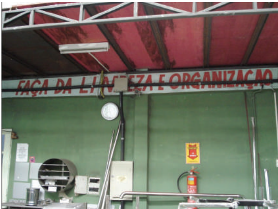
Informacional: Equipamentos em sobreposição de letreiro
