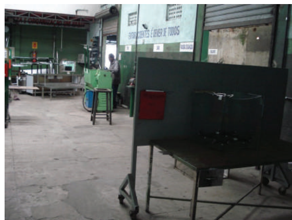
Físico-ambiental: Pouca iluminação, e a existente causa área de sombras
